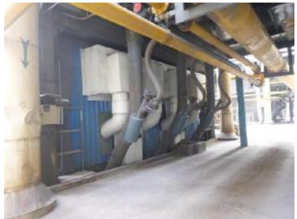
图 2-10 低氮燃烧 7 米二次风管道
